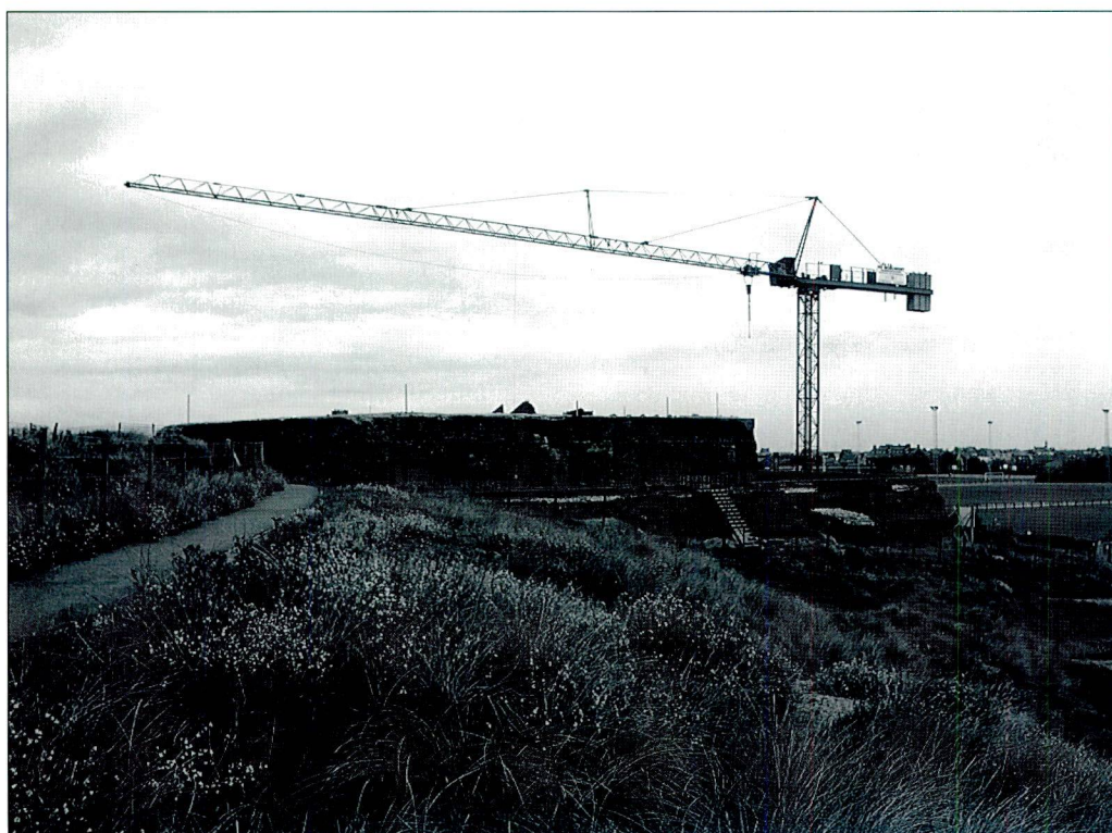
Sinds eind augustus 1995 staat een hijskraan in de Bredense duinen: in opdracht van de Stichting Vlaams Erfgoed wordt het Fort Napoleon gerestaureerd.
